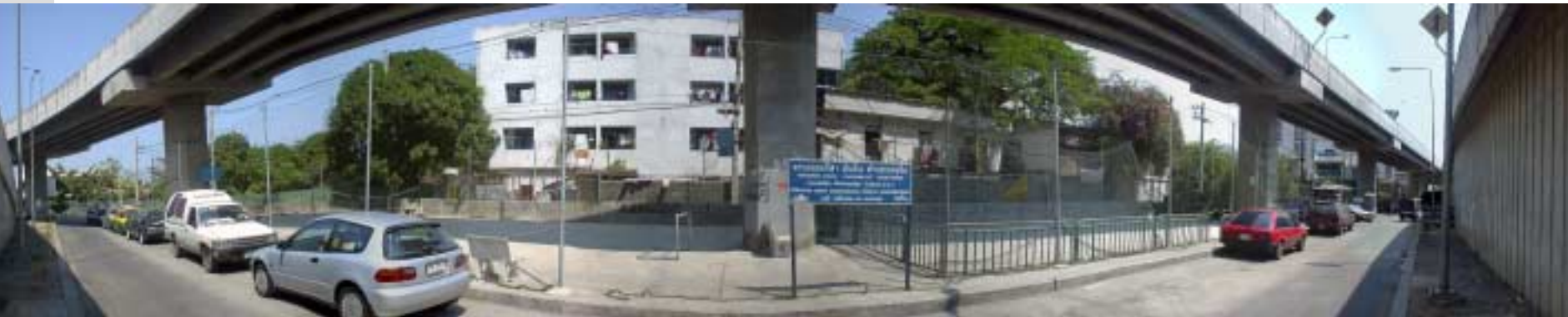
Examples of spaces under ETA expressway
