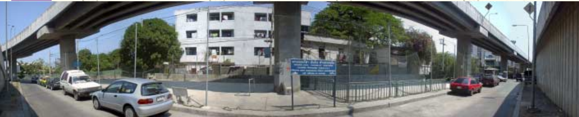
Examples of spaces under ETA expressway
